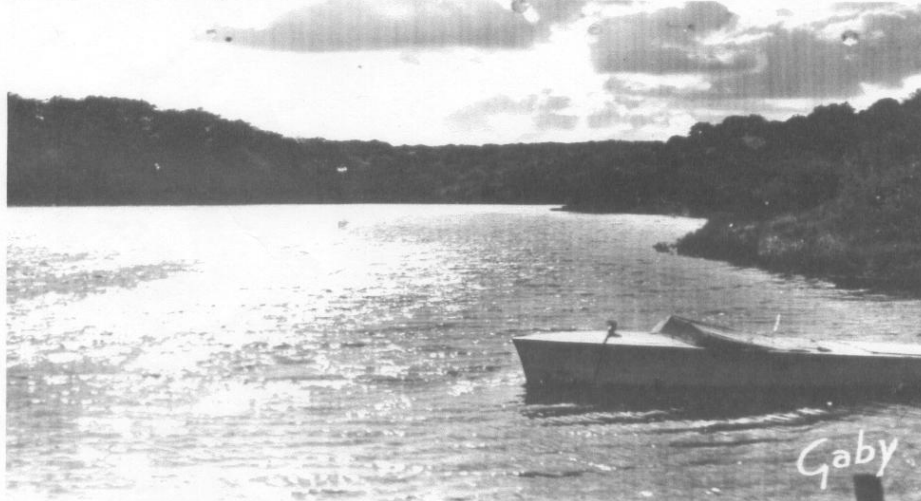
Le Barrage des Loges à Gourdin, 1958
