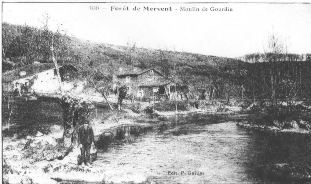
à gauche au premier plan: le Jardin de la rivière 842; derrière, la Maison de la Poulée 815,17,18; plus à droite la Maison de Mtre Boutet accolée au moulin à farine 836,37; plus à droite les ruines du moulin à foulon 835, la chaussée 834, devant la verrière, au fond le "Tra de Gourdin" et le Triage des Ecossais.
